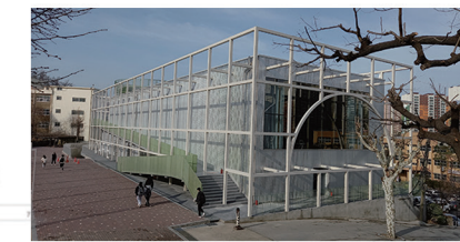
다목적 교육시설 어울림동
